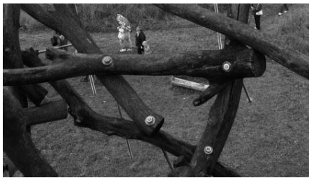
Figure 2 : bois solidarisés au moyen de tiges filetées - détail d'une réalisation de Polisky
